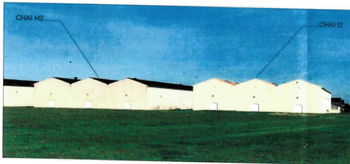
PC7 - PHOTOGRAPHIE ETAT DES LIEUX DE L'ENVIRONNEMENT PROCHE
